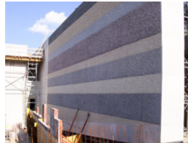
Die farbigen Betonschichten
